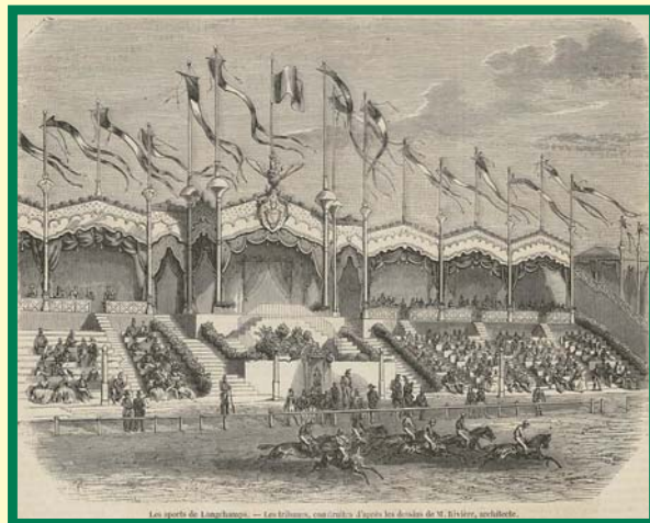
Les sports de Longchamps - Les tribunes, construites d'après les dessins de M. Rivière, architecte, 1854
