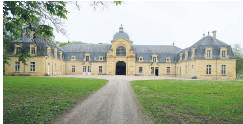
Les écuries du château de Prye s'inspirent de celles du château de Versailles en arc de cercle.
